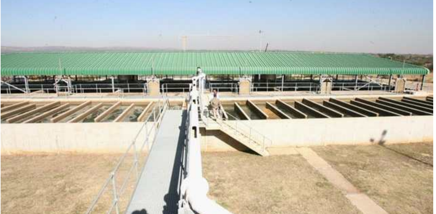
Figure 5: Roodeplaats WTP – 60ML/d Plant.
