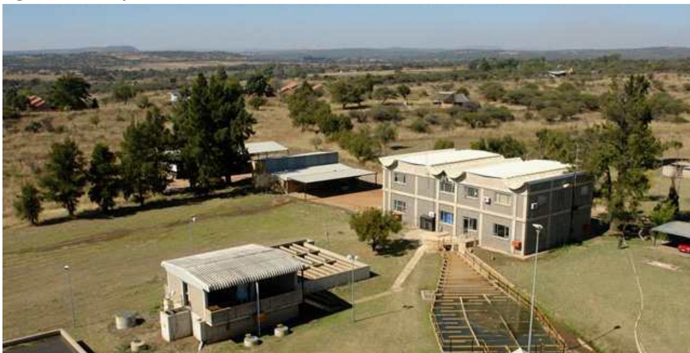
Figure 5: Roodeplaats WTP – 60ML/d Plant.
